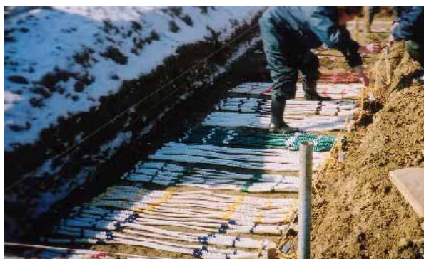
図1 ロープ埋設状況（福島県）
